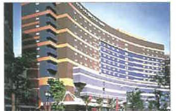
▲キャナルシティ福岡ワシントンホテル
